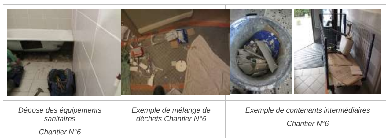
Figure 43 : Illustrations des phases de curage en milieu occupé
