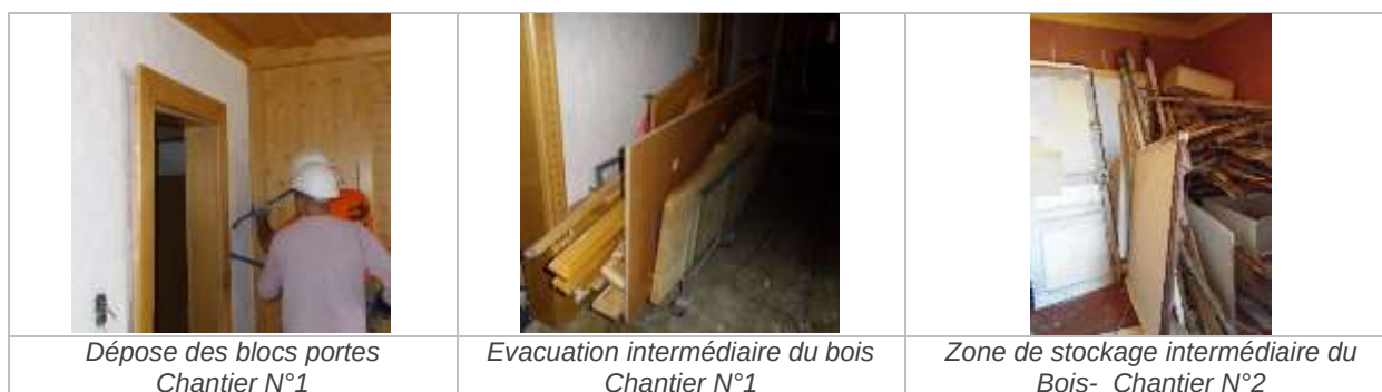
Figure 40 : Illustrations des phases de curage en milieu non occupé
