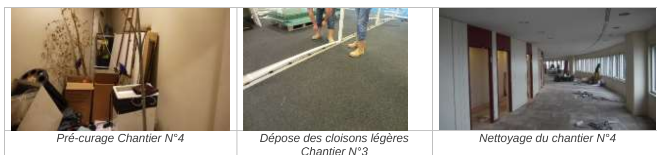
Figure 38: Illustrations des phases de curage en milieu semi occupé
